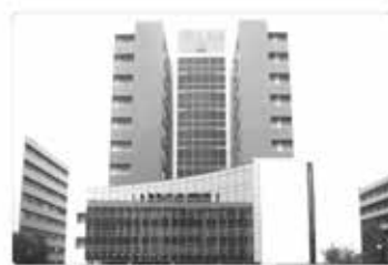
名古屋工業大学 2号館
