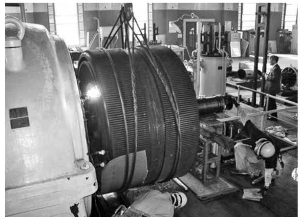
写真4. 高周波発電機の分解工事
