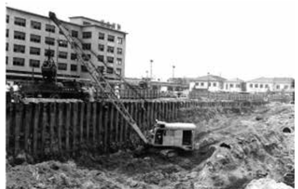
写真1. 名古屋駅前の建設工事 (すぐ後方には当時の国鉄名古屋駅が見えます。)
