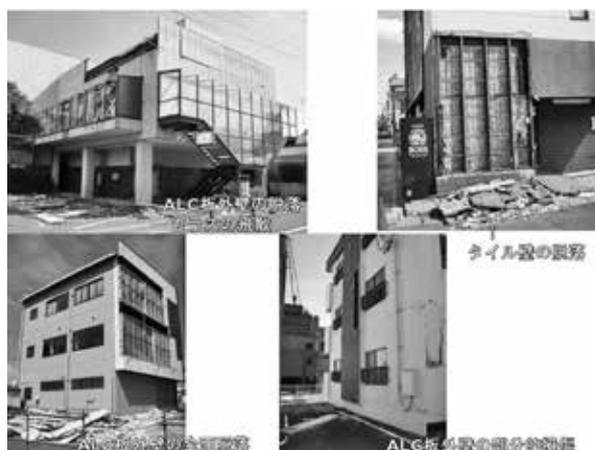
スライド7 外壁材の被害
