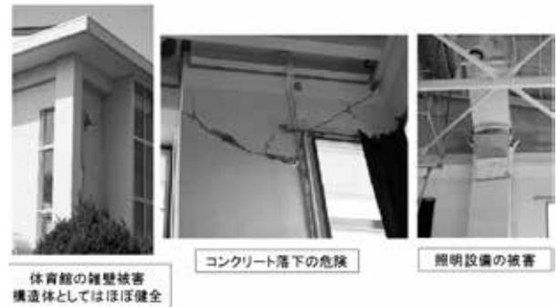
図6. 学校建物の被害事例1—体育館の雑壁被害
