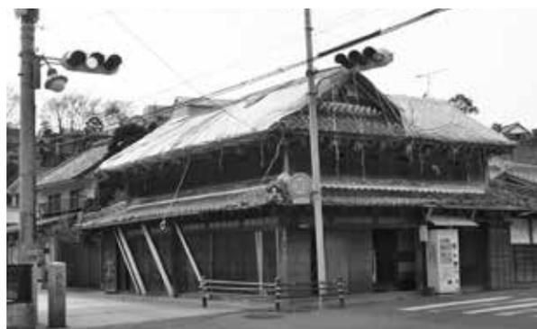
スライド5 屋根瓦が損傷した伝統木造住宅
