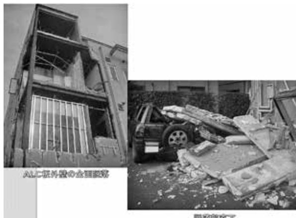
スライド6 外壁材の落下と車両大破
