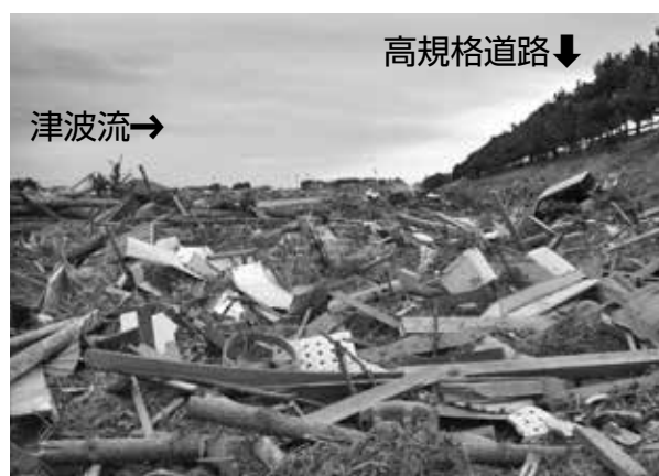
図3. 津波を堰止め、避難場所にもなった高規格道路
