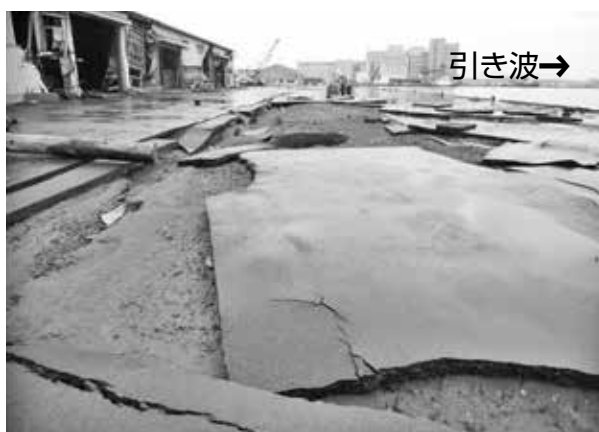
図2. 液状化と引き波による複合被害の様子
