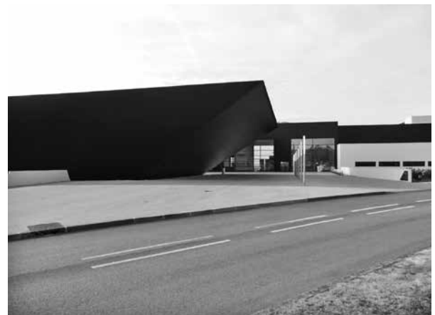
写真2. 建物外観 (左: 講義棟, 右: 研究棟)
