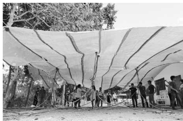
フィリピンにて一般市民との建設中のひとコマ
