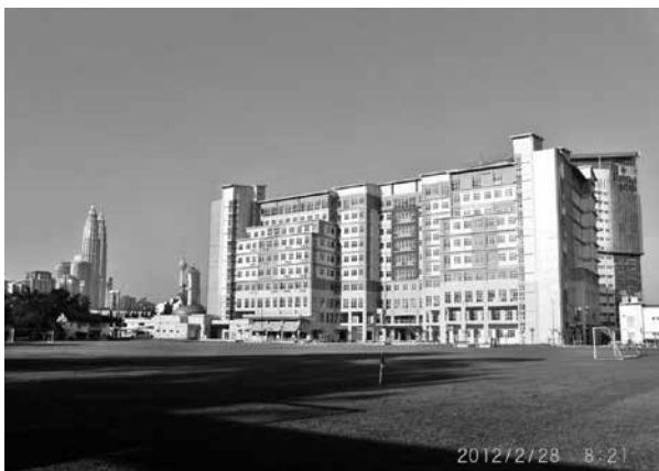
写真1. 竣工直後のMJITの10階建ての建物。 左奥にKL名所のツインタワーとKLタワーが見える。
