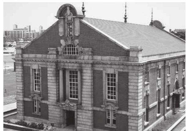
旧第一ポンプ所
