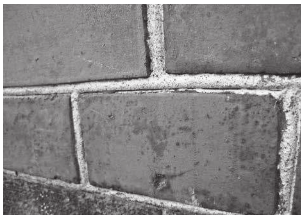
旧第一ポンプ所の覆輪目地（拡大）
