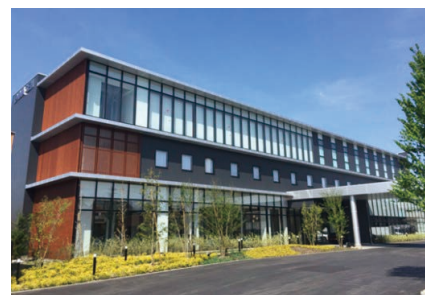
写真① 今仙電機製作所グローバル開発センター
