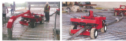
打設機：ブレーサー
