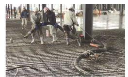
従来の配管移動作業（複数作業員による人力作業）
