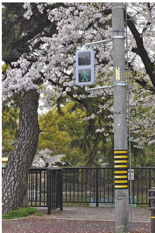
竜が池東交差点に歩行者信号が設置され、 駐車場周辺の交通安全性が高まった。
