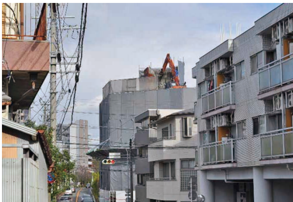
屋上ペントハウス解体（12月16日）
