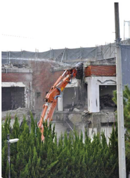
3階解体開始（12月23日）
