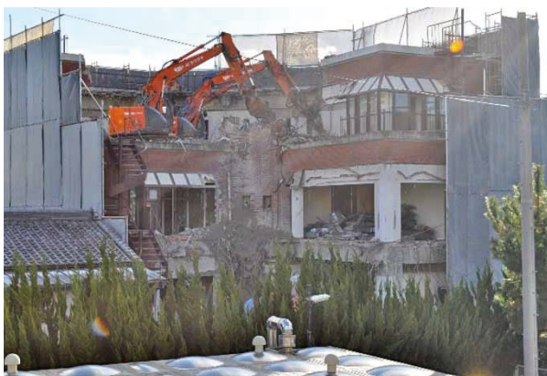
4階解体進行（12月17日）
