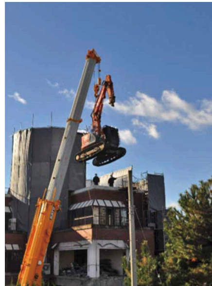
重機を屋上へ（12月16日）
