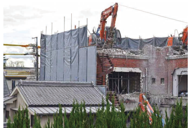
4階解体終了（12月21日）
