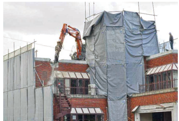
4階の解体開始（12月16日）
