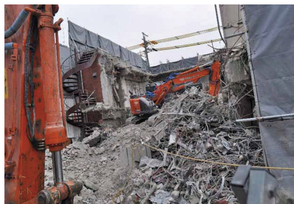
2階解体終了（12月27日）
