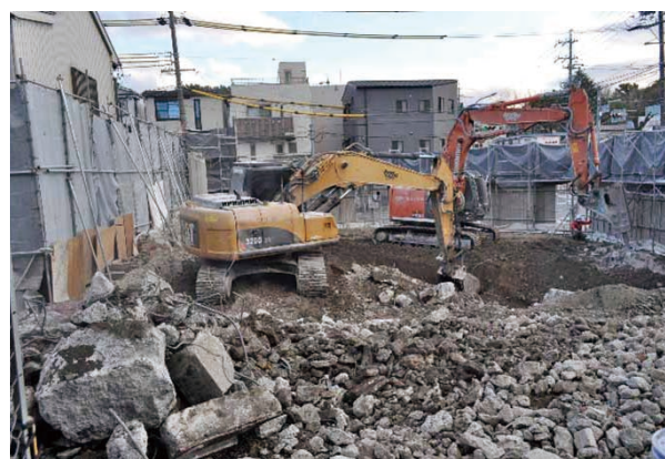
基礎撤去（1月17日）
