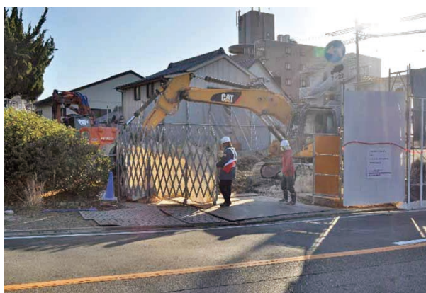
建物解体終了（1月15日）
