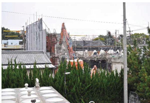
2階解体開始（12月24日）
