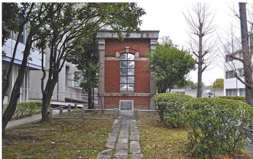
汽罐室の側壁
