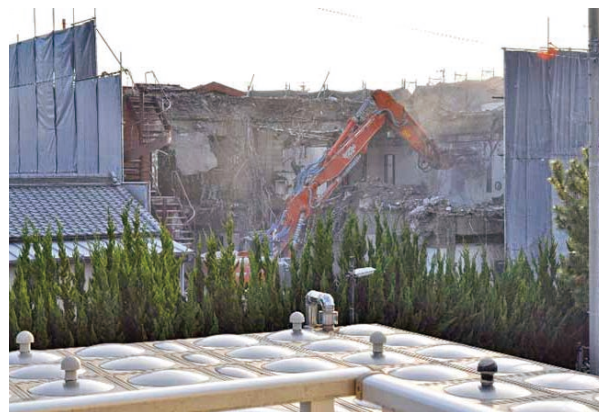
3階解体終了（12月24日）
