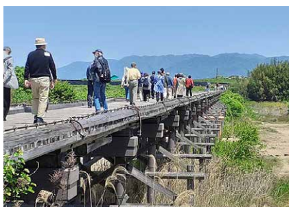
木津川流れ橋
