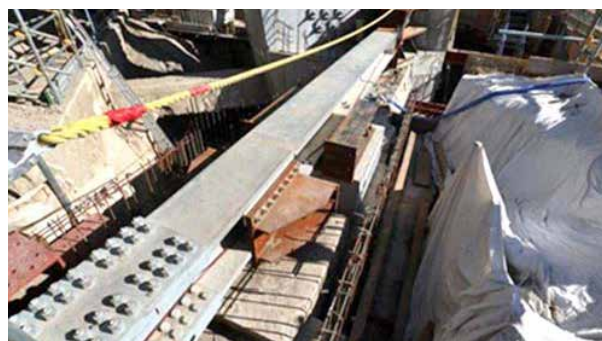
新設した鉄骨タイビーム (2019年11月撮影)
