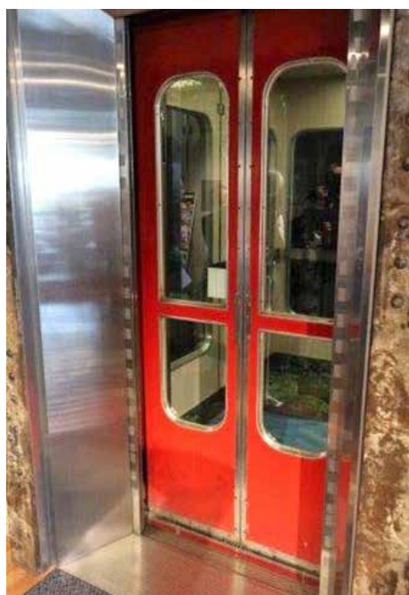
国内に唯一残る扉が手動操作のエレベータ
