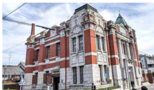
岡崎信用金庫資料館 外観
