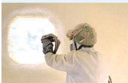
インスタントハウスの開口部の施工の様子
