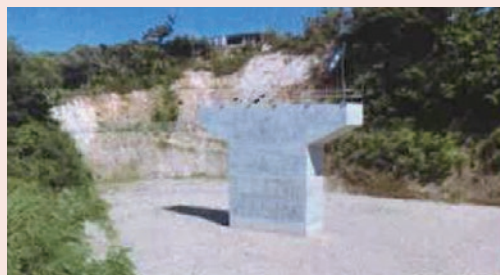
P1橋梁の完成全景
