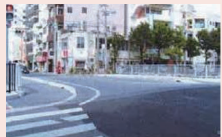
完了状況全景
