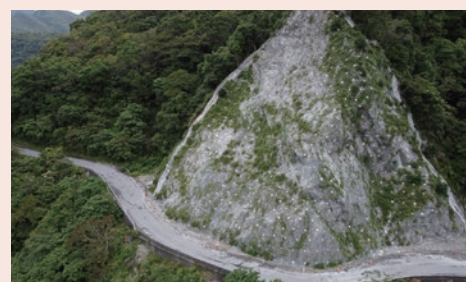
台湾花蓮、工事完了写真 出典: (株)相建エンジニアリングHPより
