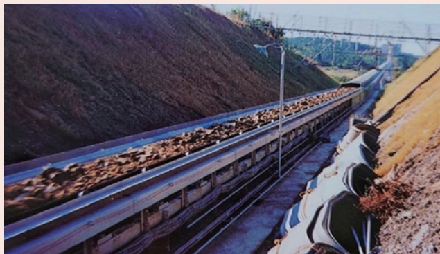
土取場より No.1 コンベアを望む 出典: 関西電力(株) 御坊発電所工事誌「人工島を築く」より
