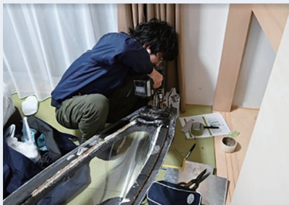
ホテルでの修復作業
