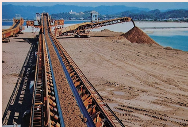
ブルコン設備による埋立(スプレッタ、AT コンベヤ) 出典: 関西電力(株) 御坊発電所工事誌「人工島を築く」より
