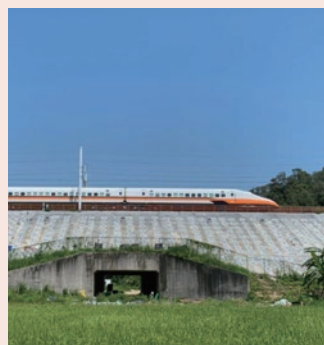
台湾新幹線 TK122、工事完了写真 出典: (株)相建エンジニアリングHPより
