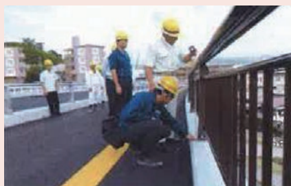
高欄高さ検測
