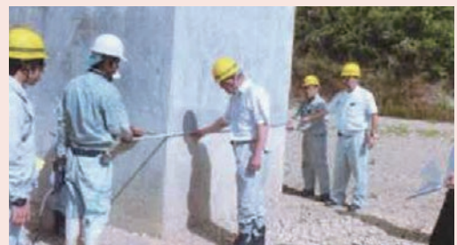
橋梁柱部の寸法検測状況
