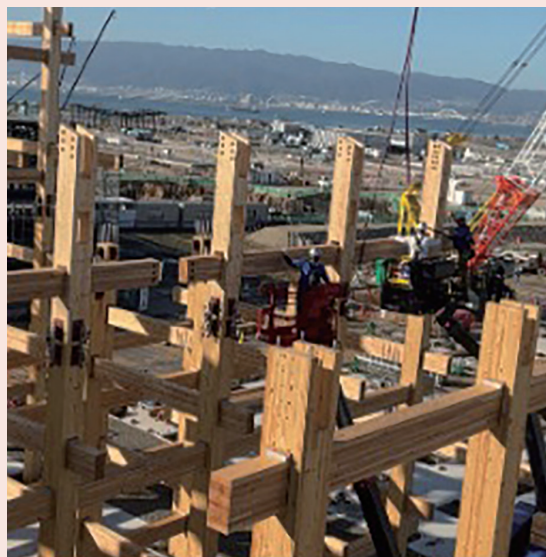
大屋根(リング)施工状況:出典株式会社竹中工務店
